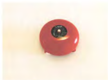
รูปที่ 2.30 กระดิ่งแจ้งเหตุ (ปกติขณะทดสอบ)
