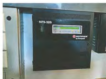
รูปที่ 2.32 Fire Control Panel
