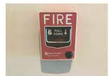
รูปที่ 2.27 อุปกรณ์แจ้งเหตุด้วยมือ (ปกติขณะทดสอบ)
