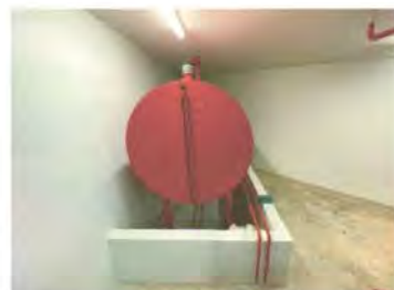
รูปที่ 2.21 ถังน้ำมันของเครื่องสูบน้ำดับเพลิง
