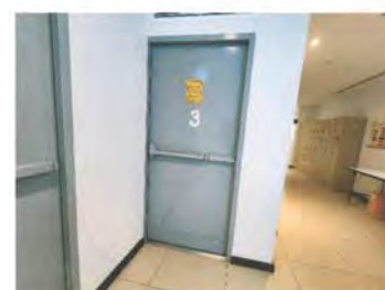
รูปที่ 2.36 ประตูหนีไฟ (ปิดสนิท มีป้ายบอกเลขชั้นชัดเจน)
