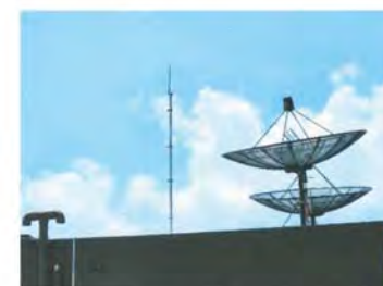
รูปที่ 2.50 ระบบป้องกันฟ้าผ่า
