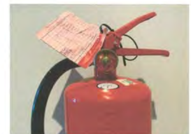
รูปที่ 2.25 ถังดับเพลิงมือถือ (สภาพถังและความดันปกติ)
