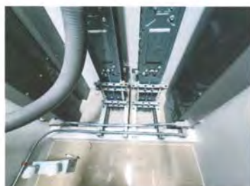
รูปที่ 2.43 การปิดกั้นช่องว่างระหว่างชั้น (ชาฟท์ไฟฟ้า)
