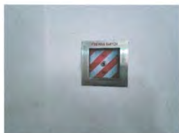
รูปที่ 2.31 สวิตช์บังคับลิฟต์ดับเพลิง
