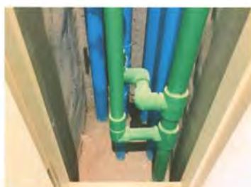
รูปที่ 2.45 การปิดกั้นช่องว่างระหว่างชั้น (ชาฟท์ท่อ)
