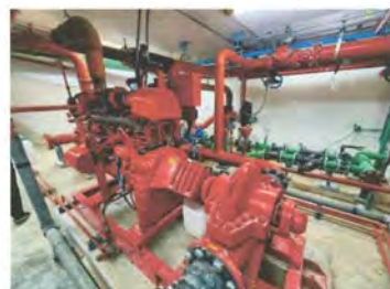
รูปที่ 2.20 เครื่องสูบน้ำดับเพลิง
