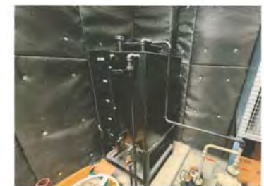
รูปที่ 2.23 ถังน้ำมันของเครื่องกำเนิดไฟฟ้าสำรอง
