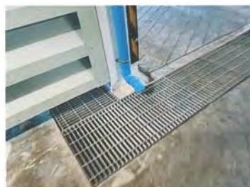
รูปที่ 2.52 ทางระบายน้ำรอบอาคาร
