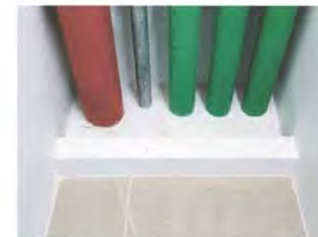
รูปที่ 2.47 การปิดกั้นช่องว่างระหว่างชั้น (ชาฟท์ท่อ)
