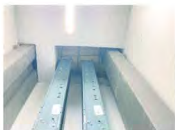
รูปที่ 2.44 การปิดกั้นช่องว่างระหว่างชั้น (ชาฟท์ไฟฟ้า)
